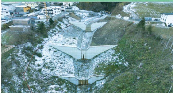
Bachverbauung Zufahrtsweg Ried
